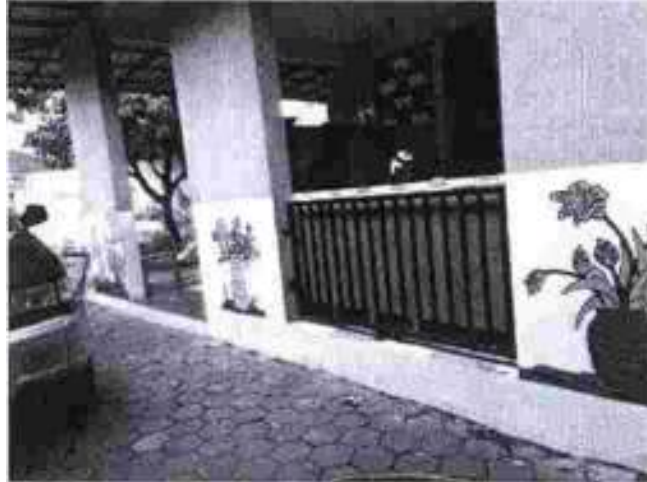
Peraga 5. Gedung Firdausy sisi barat tampak samping
